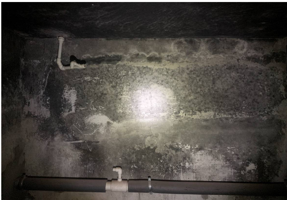
Рисунок 2.9 Отложение продуктов горения на поверхности стен и перегородок
