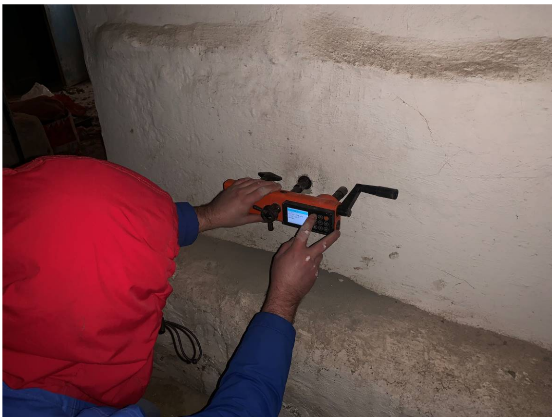
Рисунок 3.10 Определение прочности бетона стен подвала (ФБС) методом отрыва со скалыванием с помощью прибора ОНИКС-1.ОС.050
