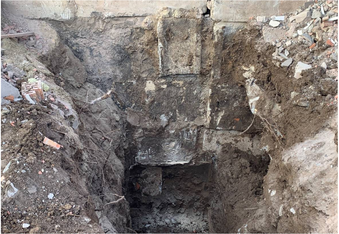
Рисунок 2.2 Общий вид шурфа 2 (между 2 и 3 подъездами)
