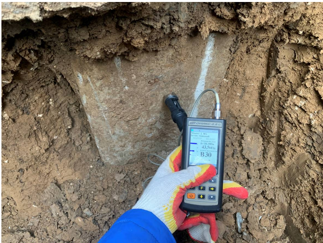
Рисунок 3.6 Определение прочности бетона ж.б. свай методом ударного импульса с помощью прибора ОНИКС-2.6
