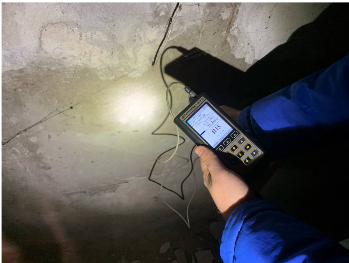
Рисунок 3.3 Определение прочности бетона стен подвала (ФБС) методом ударного импульса с помощью прибора ОНИКС-2.6.
