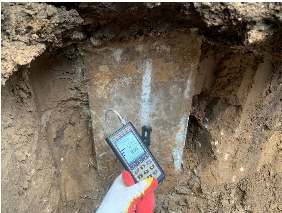
Рисунок 3.7 Определение прочности бетона ж.б. свай методом ударного импульса с помощью прибора ОНИКС-2.6
