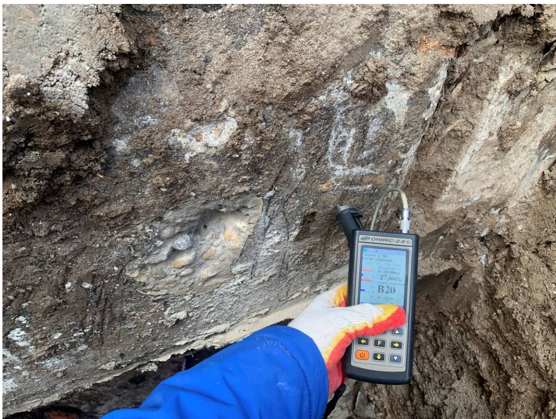
Рисунок 3.5 Определение прочности бетона ж.б. ростверка методом ударного импульса с помощью прибора ОНИКС-2.6
