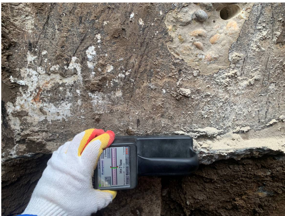
Рисунок 3.14 Определение положения арматурных стержней ж.б. ростверка с помощью ПОИСК-М
