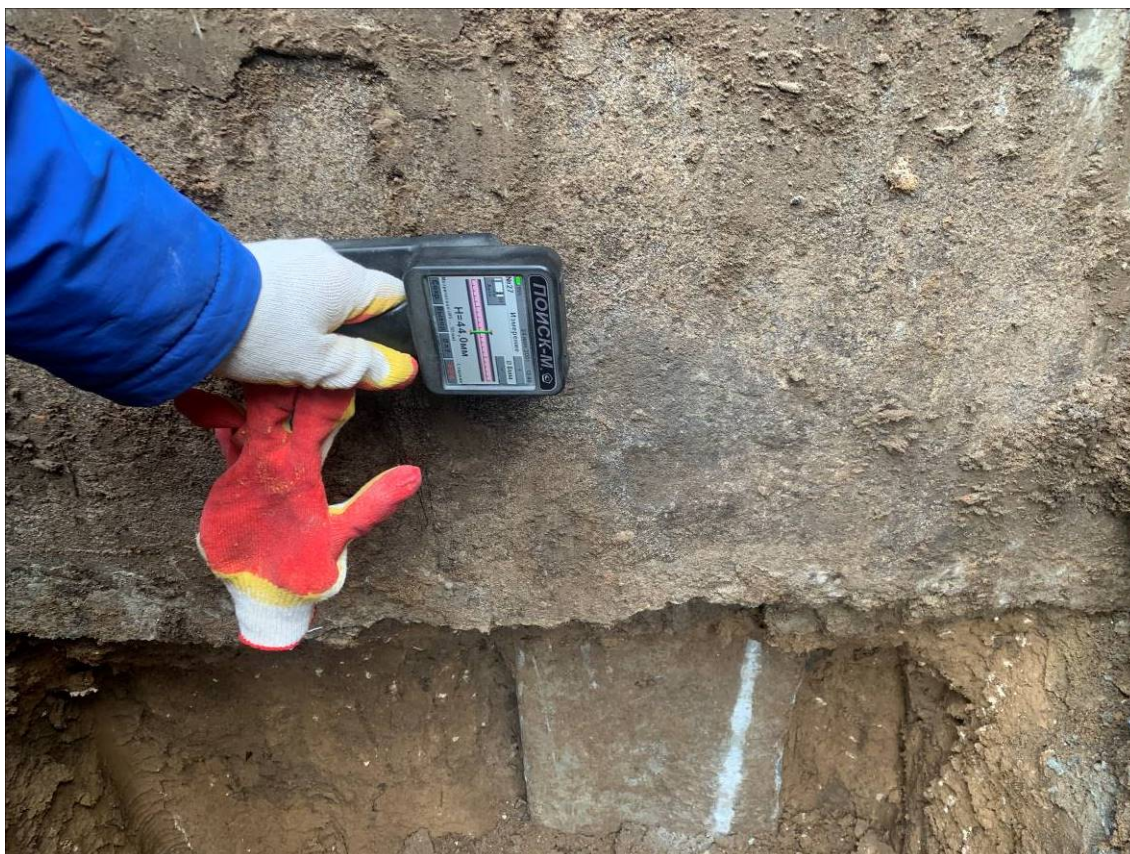
Рисунок 3.13 Определение положения арматурных стержней ж.б. ростверка с помощью ПОИСК-М
