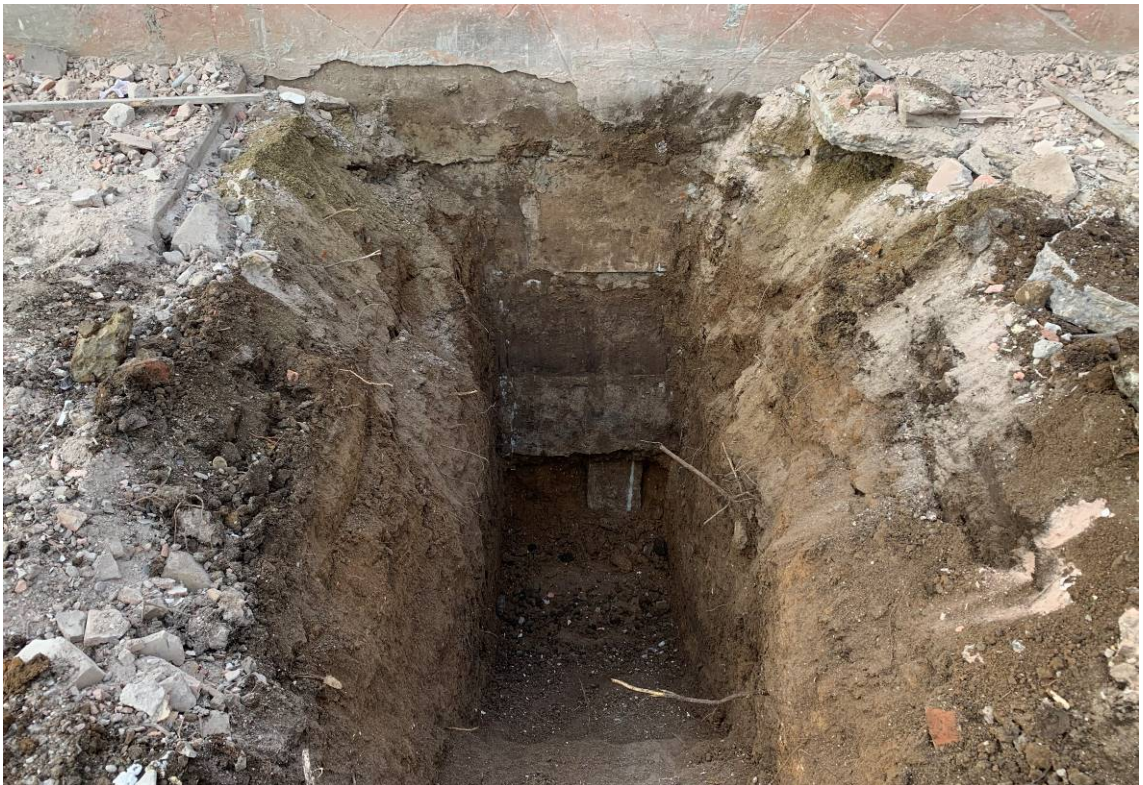
Рисунок 2.3 Общий вид шурфа 3 (4 подъезд)
