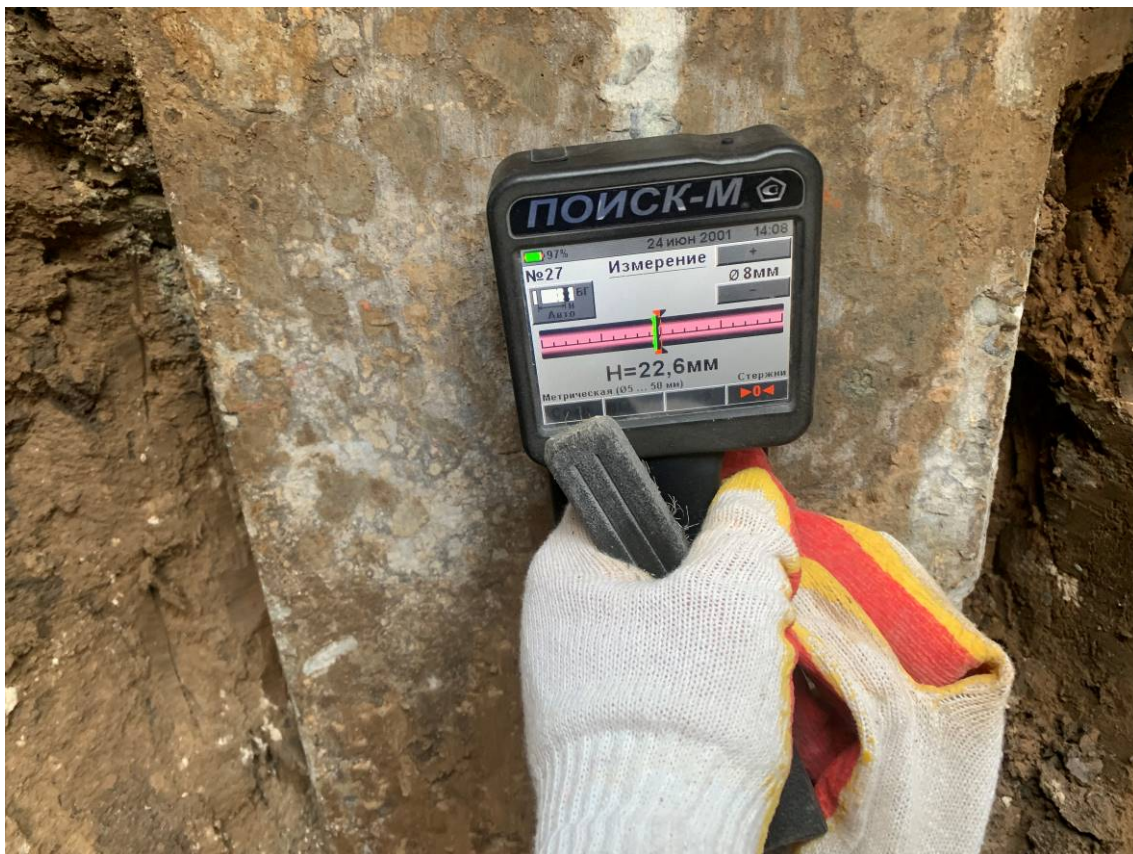
Рисунок 3.15 Определение положения арматурных стержней ж.б. свай с помощью ПОИСК-М
